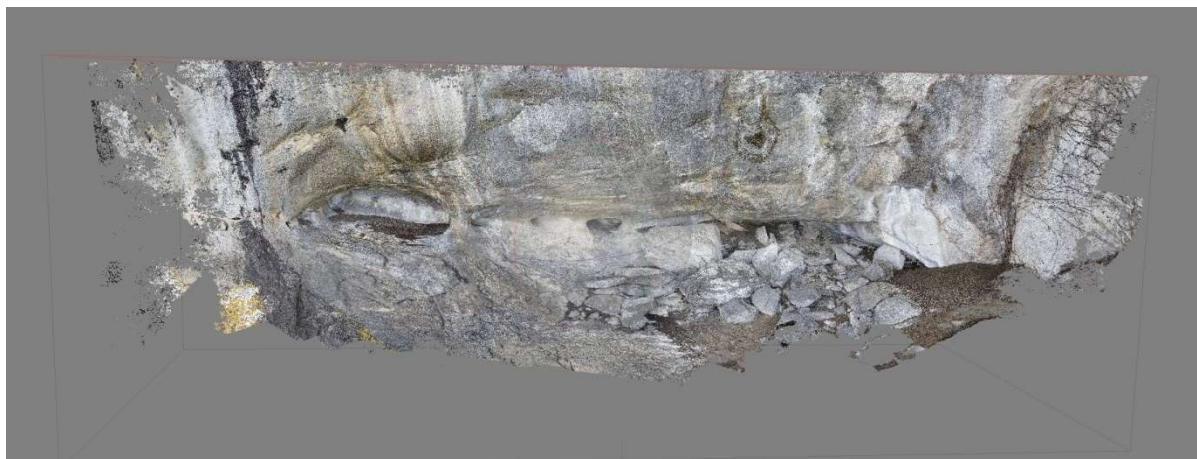
Figure 14 : Les différentes étapes de la construction du modèle 3D en photogrammétrie : texturage. Acquisition et traitement du processus photogrammétrie sous Agisoft Photoscan par O. Huard
