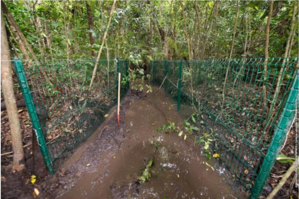
Figure 9 : Enclos piège à double entrée en cours de construction
